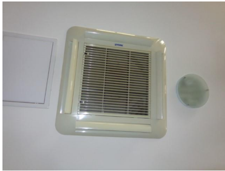
Slike 11 do 15 Fan coili, kasetne jedinice.....
